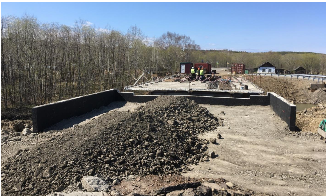
Фото 3. Работы по ремонту моста через реку Тихменевка
