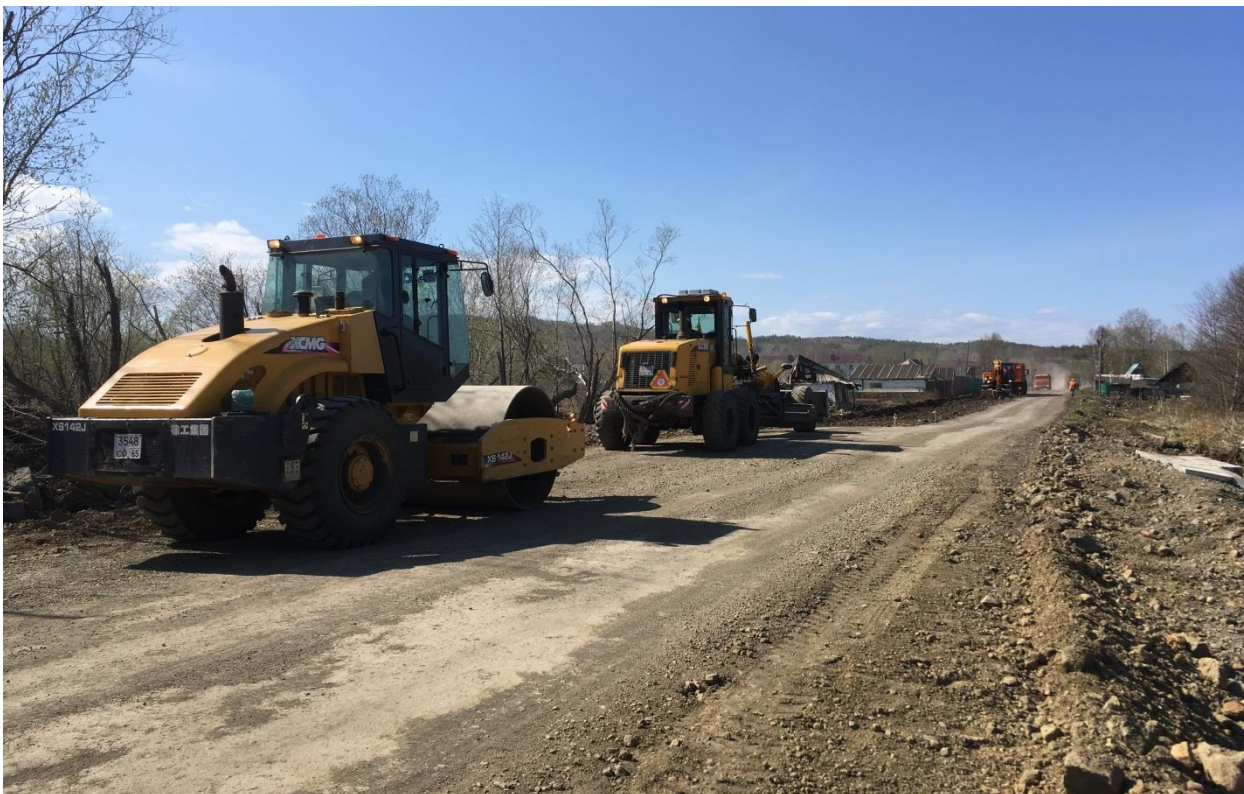
Фото 2. Работы по ремонту земляного полотна
