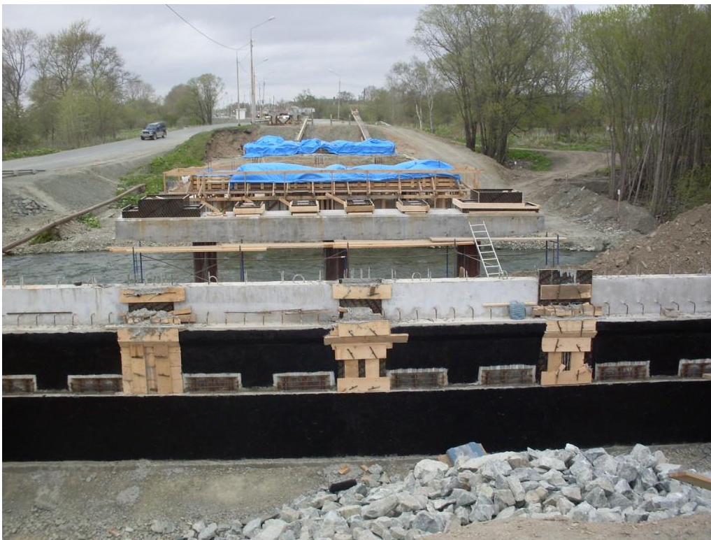
Фото 2. Ремонт крайних опор на мосту через р.Белая
