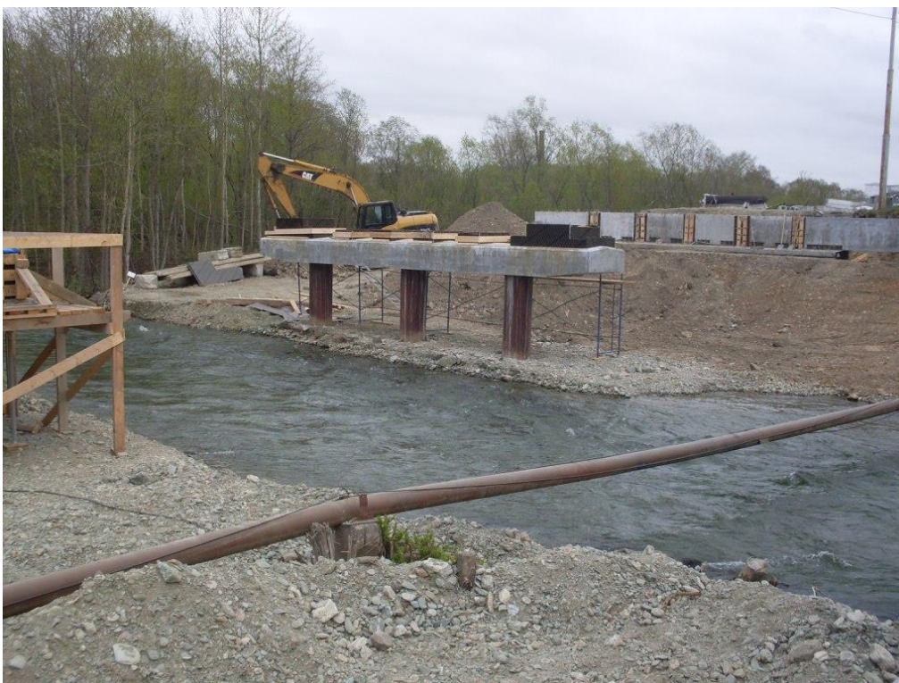
Фото 3. Ремонт промежуточных опор через р.Белая
