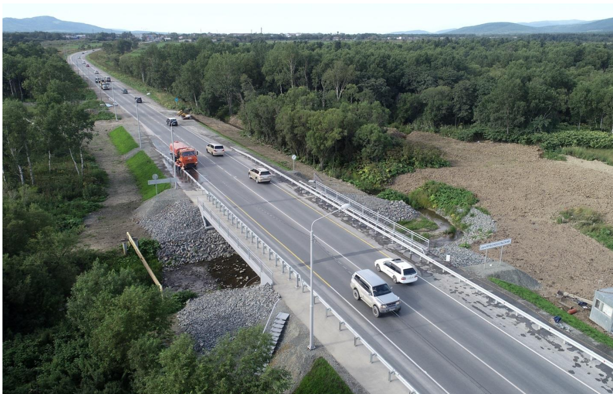
Фото 1. Мост через ручей Красносельский
