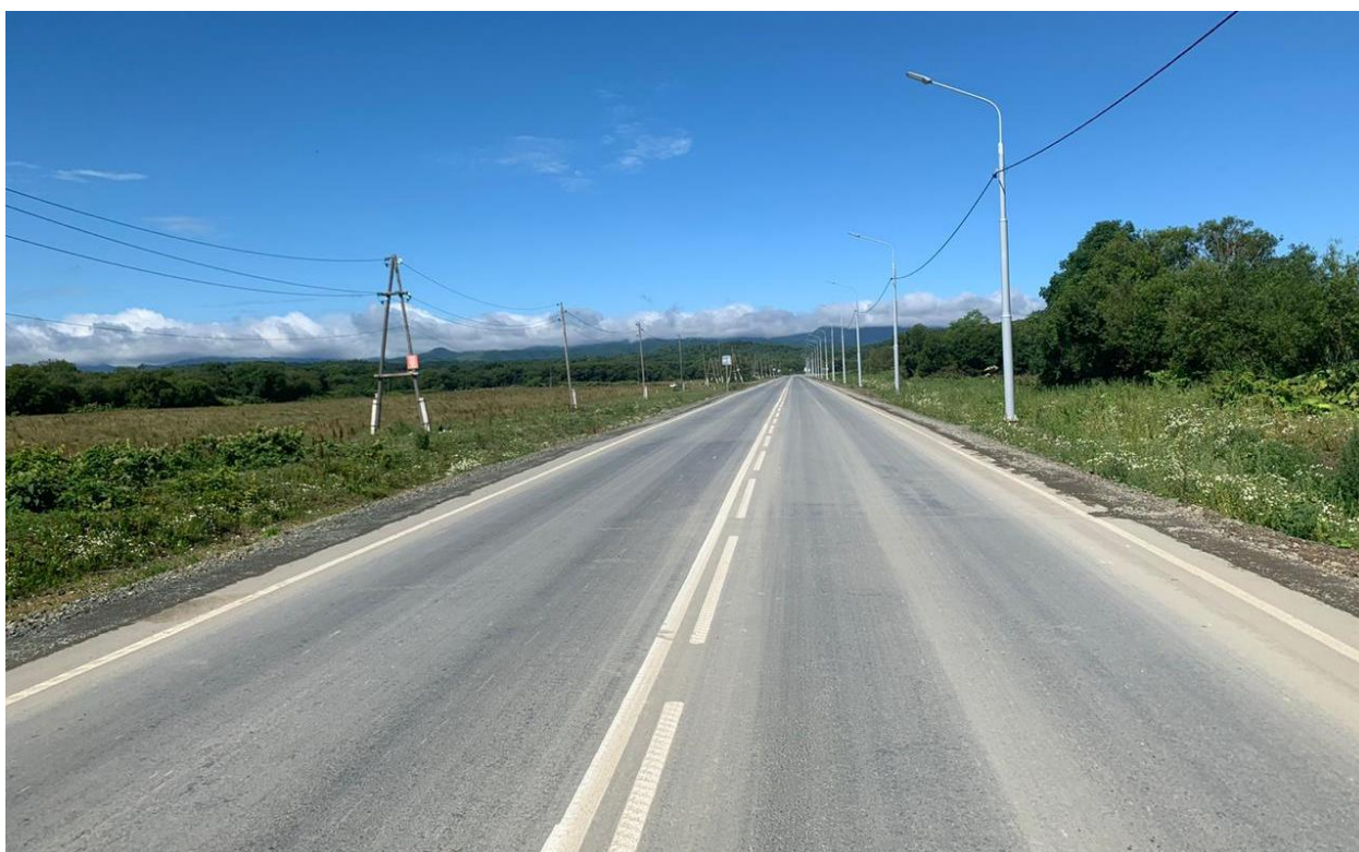
Фото 2. Реконструкция дороги Дальнее - Елочки
