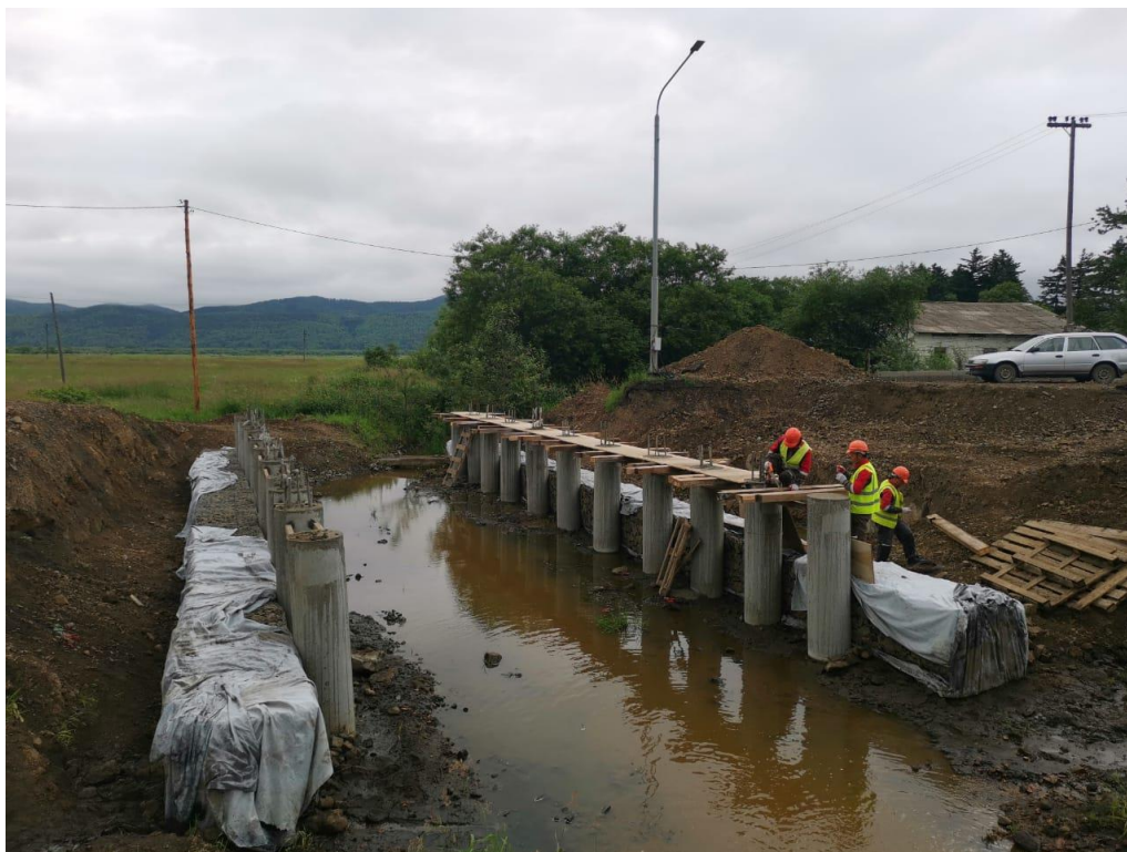
Фото 2. Установка опалубки монолитной насадки на опоре № 1
