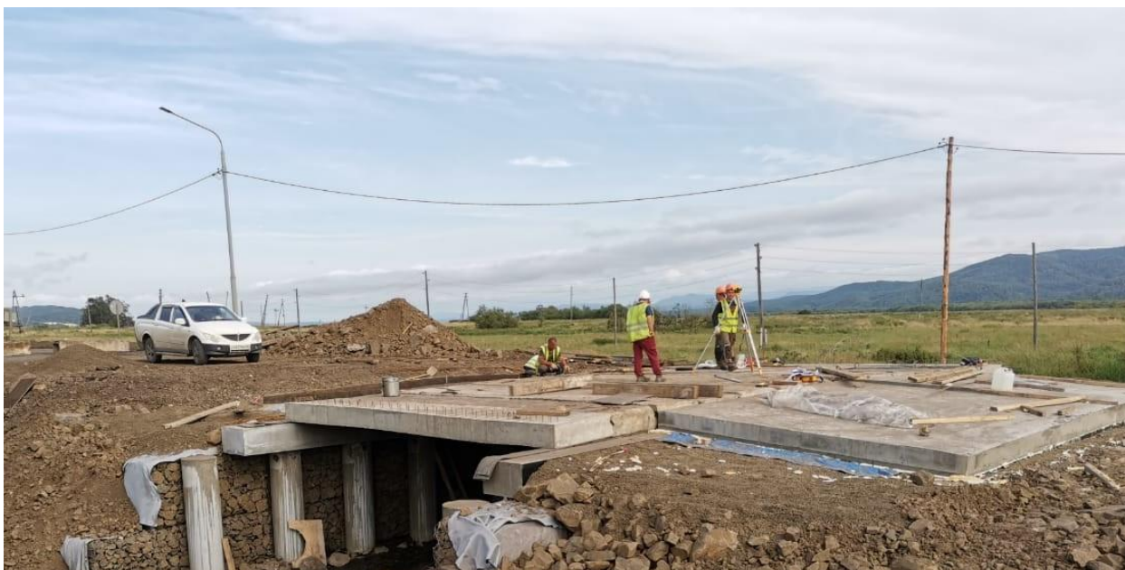
Фото 2. Установка опалубки для омоноличивания плит пролетного строения
